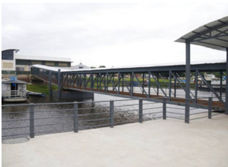
Terminal de Curuá
