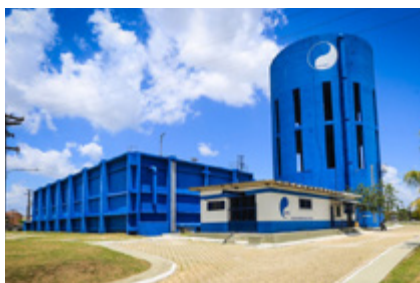
Sistema de água CDP
