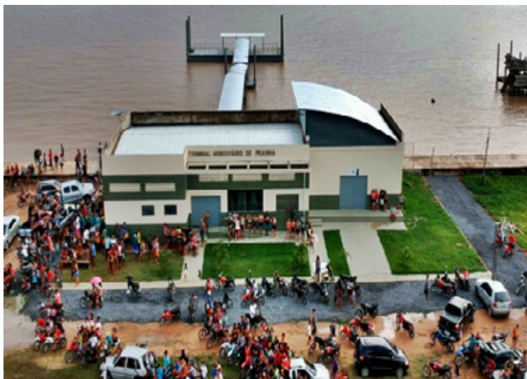
Terminal Hidroviário de Prainha
