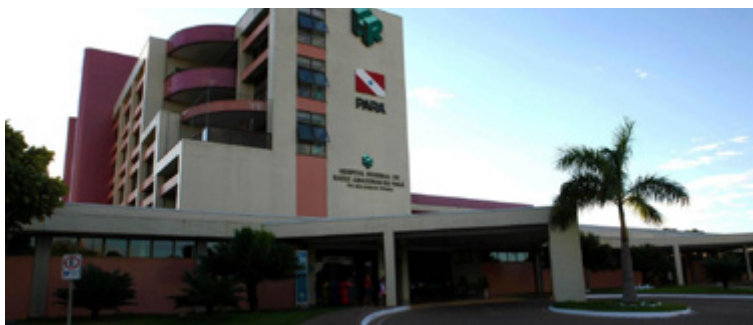
Hospital Regional do Baixo Amazonas
