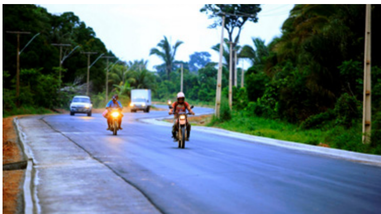
Pavimentação dos primeiros três quilômetros da rodovia PA-429, em Curuá
